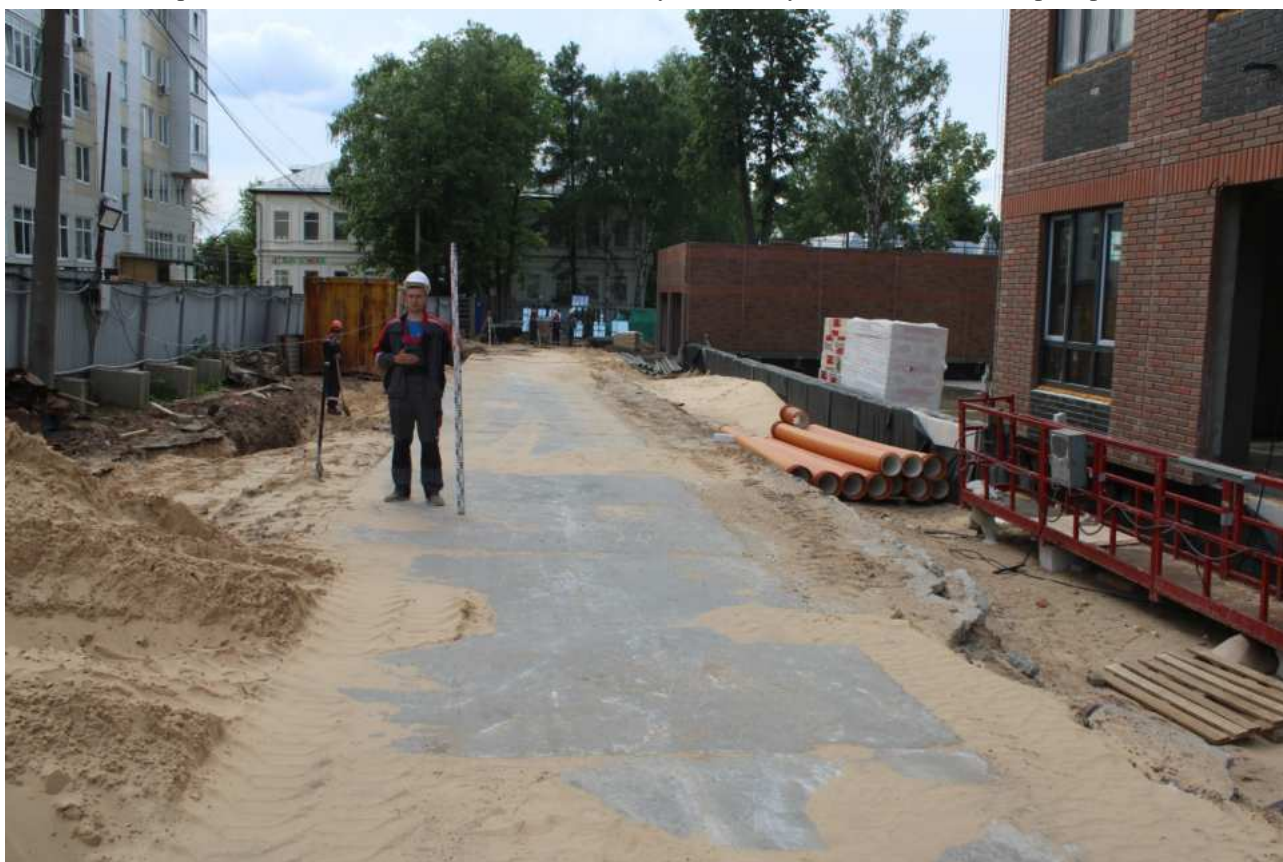
Илл.28. Общий вид земельного участка, отведенного для расположения объекта «Квартальная теплотрасса от кот. в 30 м на ЮЗ от дома №7 по ул. Дальняя (ТК-4)». Адрес (местоположение): г. Нижний Новгород, Нижегородский район, от ТК-4 в 60м на ЮЗ от 3 угла д.1в по ул. Шевченко до т. на границе сетей инженерно-технического обеспечения строящегося жилого дома в 40 м на СЗ от С угла д.2 по ул. Одесская». Точка фотофиксации 2. Вид с запада.
