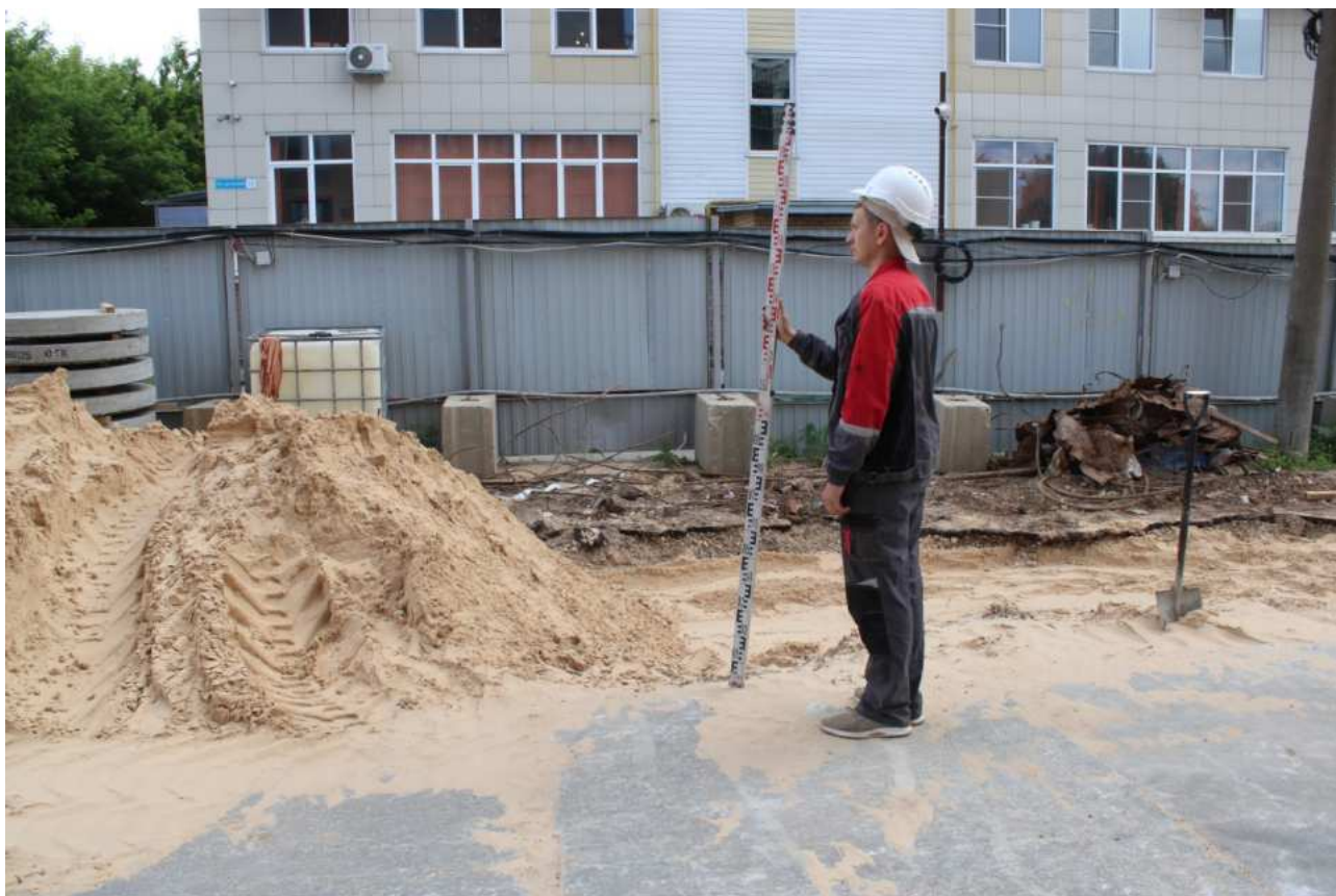
Илл. 27. Общий вид земельного участка, отведенного для расположения объекта «Квартальная теплотрасса от кот. в 30 м на ЮЗ от дома №7 по ул. Дальняя (ТК-4)». Адрес (местоположение): г. Нижний Новгород, Нижегородский район, от ТК-4 в 60м на ЮЗ от 3 угла д.1в по ул. Шевченко до т. на границе сетей инженерно-технического обеспечения строящегося жилого дома в 40 м на СЗ от С угла д.2 по ул. Одесская». Точка фотофиксации 2. Вид с
